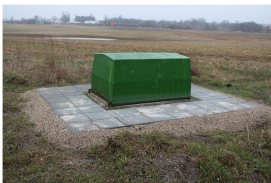
Boring med DGU nr. 200.6375.
