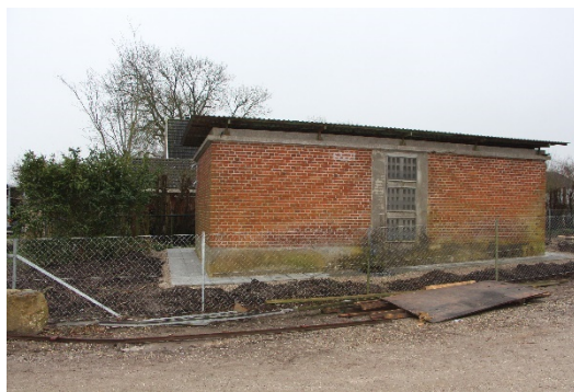
Vandværket fra adgangsvej.
