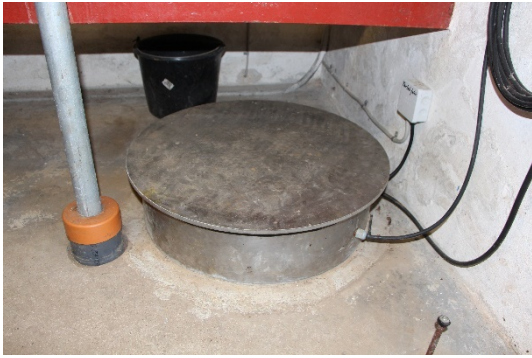
Nyt dæksel til rentvandstanken.
